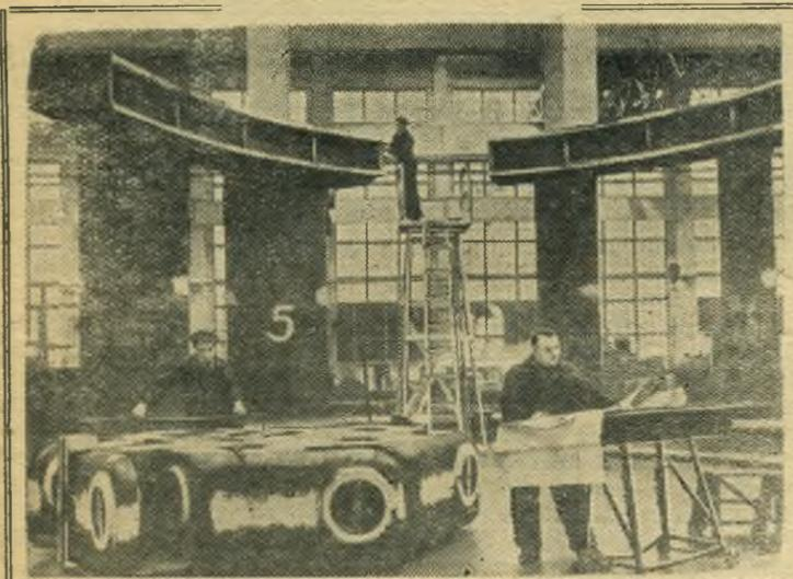
Ленинград. В гидротурбинном цехе металлического завода имени Сталина идет механическая обработка деталей турбины для Куйбышевской ГЭС. Над изготовлением этой сверхмощной машины трудятся лучшие рабочие — мастера турбостроения.
