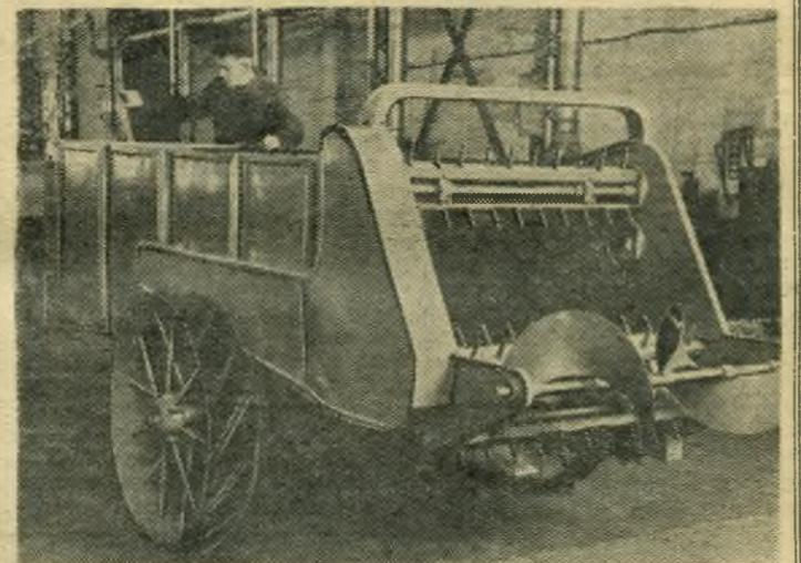
Украинская ССР. На Осипенковском заводе дорожных машин изготовлен головной образец новой сельскохозяйственной машины — навозоразбрасывателя «НТ-2», который прицепляется к трактору «Универсал». Производительность машины 1—1,5 гектара в час. Емкость кузова 3 кубических метра, ширина разбрасывания до 2,5 метра.
