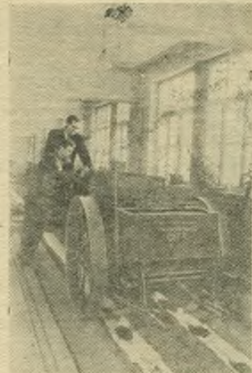
НА СНИМКЕ: Руководитель лаборатории Всесоюзного научно-исследовательского института механизации сельского хозяйства лауреат Сталинской премии В. Д. Павлов (справа) и инженер А. В. Селиванов проверяют работу картофелесажалки «СКГ-4» с приспособлением для внесения минеральных удобрений.
