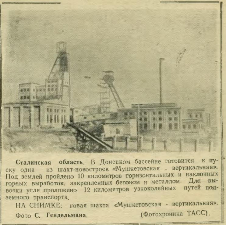
Сталинская область. В Донецком бассейне готовится к пуску одна из шахт-новостроек «Мушкетовская - вертикальная». Под землей пройдено 10 километров горизонтальных и наклонных горных выработок, закрепленных бетоном и металлом. Для вывозки угля проложено 12 километров узкоколейных путей подземного транспорта.
