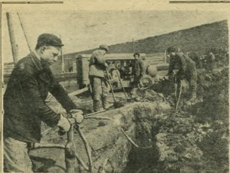
Строительно-монтажное управление Центрпроудстроя (начальник М. Я. Филичкин) приступило к сооружению здания административно-хозяйственного корпуса в районе крупозавода № 24.
