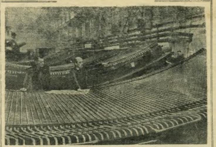
Ленинград. Коллектив завода «Электросила» имени С. М. Кирова успешно завершил изготовление первого уникального гидротурбогенератора для Куйбышевской ГЭС. Новая машина по своим данным не имеет равных в мире. Вес ее 1.600 тонн, диаметр по корпусу свыше 17 метров. Машина вырабатывает такое количество электроэнергии, которое может обеспечить город с населением в 300 тысяч человек.
