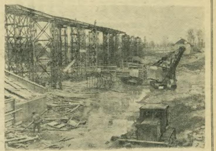
Эстонская ССР. На третьем участке строительства Нарвской ГЭС, где сооружается водосливная плотина, заканчивается монтаж бетоновозной эстакады. По ней будет подаваться бетон в блоки плотины. Идет также выемка скального грунта под основную водобойную часть плотины. НА СНИМКЕ: на строительстве водосливной плотины. Фото В. Самусенко. (Фотохроника ТАСС).
