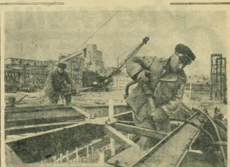
Новосибирская область. На строительстве Новосибирской гидроэлектростанции идет монтаж арматуры и укладка бетона. В текущем году строителям предстоит уложить в основные сооружения будущей гидроэлектростанции первые 125 тысяч кубометров бетона.
