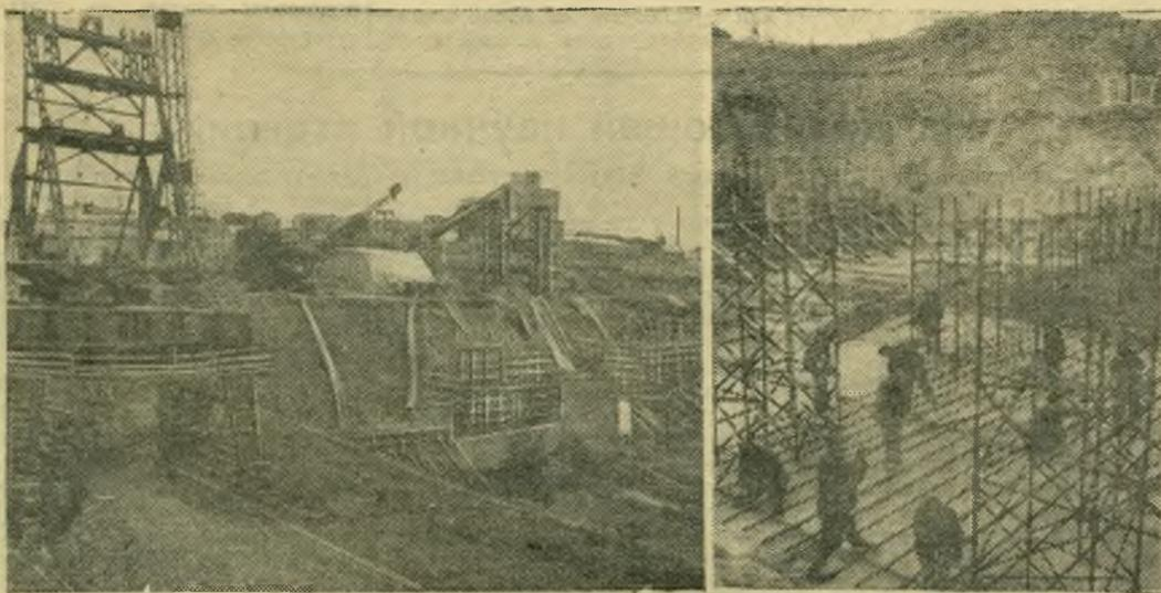
Новосибирская область. С каждым днем расширяется фронт работ на строительстве Новосибирской гидроэлектростанции. НА СНИМКАХ: (слева) общий вид работ по бетонированию в котловане под здание ГЭС; (справа) монтаж арматуры в верхнем головном сооружении шлюза. Фото В. Лещинского. (Фотохроника ТАСС).
