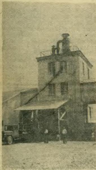
башня может принять и разгрузить по складам 100 тонн зерна.
