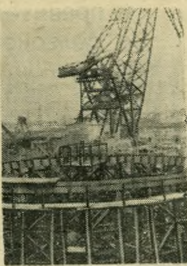
Горьковская область. Монтаж первой турбины Горьковской гидроэлектростанции.
