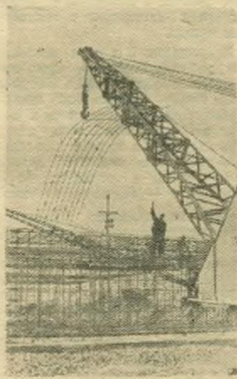
Сталинградгидрострой. В котловане ГЭС и водосливной плотины развернулись бетонные работы. Одновременно с укладкой бетона в фундаментные плиты ведется установка железной арматуры.
