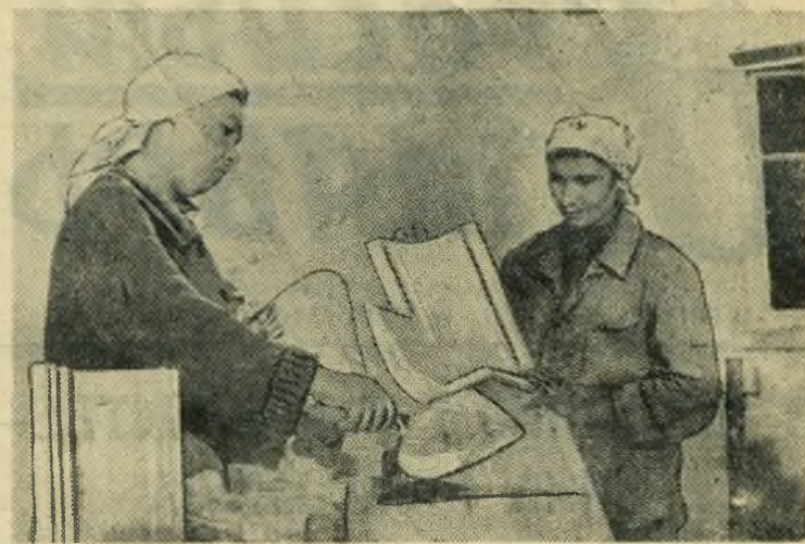
На участке № 2 строительного треста № 112 организовано производство сборных карнизов. Работницы тт. Абукина и Лаврушкина задание по отливке карнизов в августе выполнили на 157 процентов.
