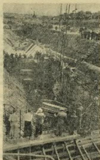
На строительстве Сталинградской ГЭС произведена закладка здания гидроэлектростанции. В основание здания были уложены первые кубометры бетона.
