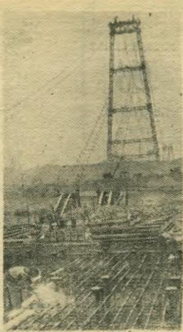
Сталинградгидрострой. Рядом с котлованом под здание ГЭС ниже по течению Волги идет сооружение четвертого ряда рисбермы. После окончания строительства станции рисберма скроется под водой.
