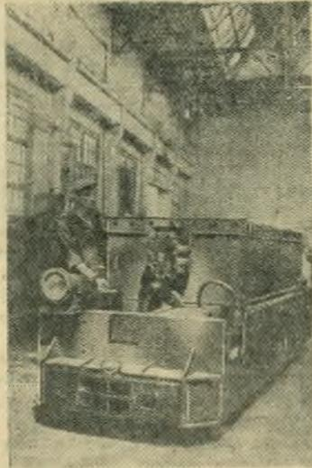
Сталинская область. Торский завод горного машиностроения имени Ворошилова изготавливает различное оборудование для угольных шахт. Налажен серийный выпуск мощных унифицированных аккумуляторных электровозов «8-АРВ».
