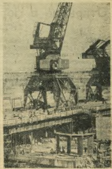
Новая Каховка. Строители Каховского гидроузла приступили к монтажу первой турбины гидроэлектростанции.
