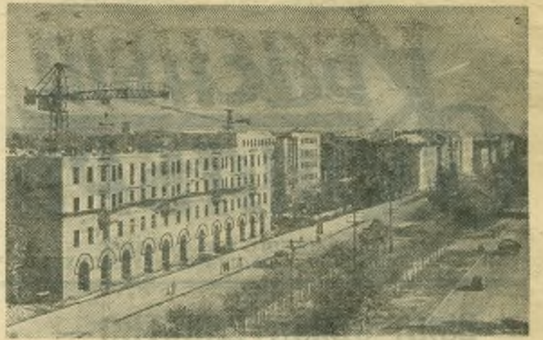
Алтайский край. Строительство жилых домов на Ленинском проспекте в Барнауле.
