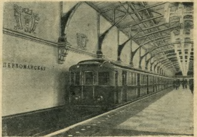
Москва. Завершено сооружение первой наземной станции метрополитена «Первомайская». Новая станция, расположенная в Измайлове, соединена наземным и подземным путем с действующей линией метро.
