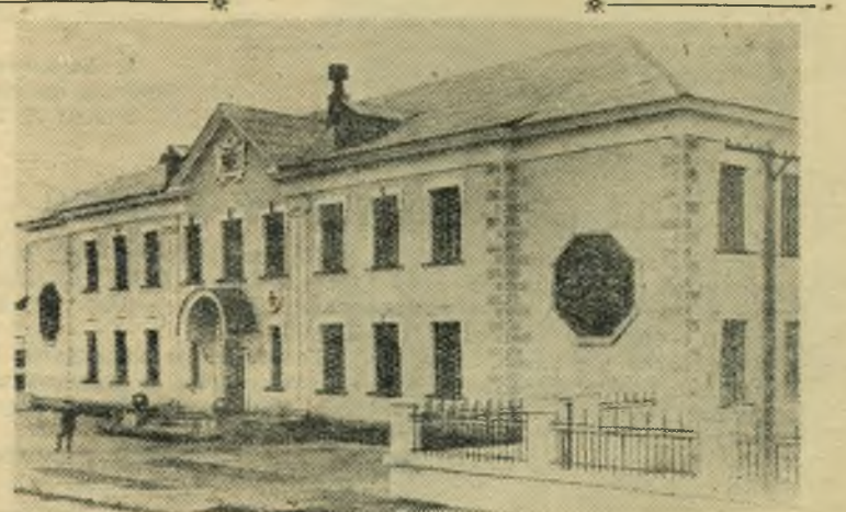
НА СНИМКЕ: здание средней школы № 28 в поселке «Строитель», построенное в 1954 году.
