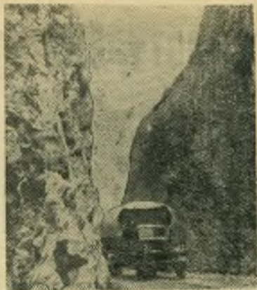
Китайская Народная Республика. Через Тибетское плато известное под названием «Крыша мира», строится Сикан-Тибетская шоссе-ная дорога протяженностью 2.255 километров. Большие трудности приходится преодолевать строителям — ряд участков дороги проходит на высоте 4.000 метров над уровнем моря. Недавно открылось движение на 872-километровом участке.
