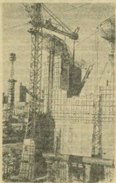
Куйбышевгидрострой. Первый пусковой объект Куйбышевского гидроузла — двухкамерные судоводные шлюзы — вступит в строй весной 1955 года.
