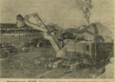
Удмуртская АССР. Ширится фронт подготовительных работ на строительстве Воткинской ГЭС. Идет прокладка железнодорожной линии от станции Кварсы. Сооружается автоматистражь протяженностью 23 километра. Здесь предстоит вынуть и переместить около миллиона кубометров грунта. Половина этих работ уже выполнена. НА СНИМКЕ: погрузка грунта в думпкары для отправки на строительство железнодорожной линии.
