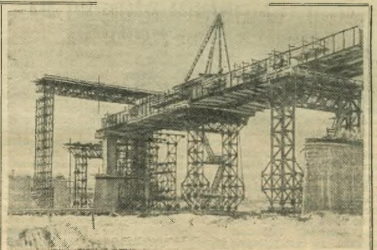
Башкирская АССР. В Уфе идет строительство крупного железобетонного моста через реку Белую для автогужевого транспорта. Он свяжет левобережные районы Башкирии с Уфой. За короткий срок строители уложили свыше 10 тысяч кубометров бетона и железобетона и выполнили более 100 тысяч кубометров земляных работ. Сейчас идет монтаж металлических пролетных сооружений.
