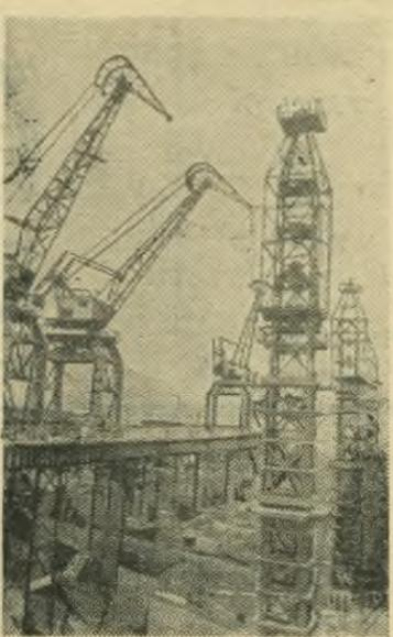
На строительстве Куйбышевской гидроэлектростанции устанавливаются телескопические краны высотой 67 метров с вылетом стрелы 40 метров для монтажа гидротурбин и гидрогенераторов.
