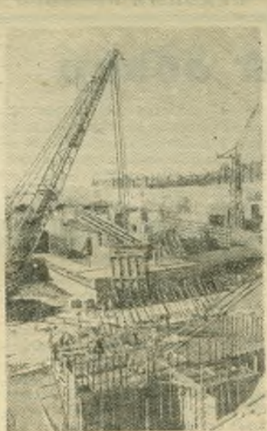
В Таджикистане, близ Ленинабада, на реке Сыр-Дарье строится крупнейшая в Средней Азии Кайраккумская гидроэлектростанция. НА СНИМКЕ: в котловане Кайраккумской ГЭС. Укладка бетона в опоры бетонной эстакады.
