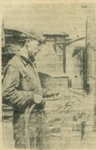
Ежедневно более трех норм выработывает электрогазосварщик вагонного участка ст. Сызрань 1-я тов. Ляхов, участвующий во всесоюзном соревновании за досрочное выполнение пятой пятилетки.
