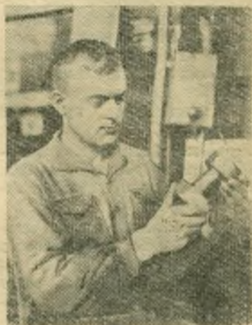
Токарь второго цеха гидротурбинного завода тов. Гапеев еще в прошлом году завершил выполнение своей пятилетней нормы. Сейчас он также значительно перевыполняет нормы выработки. Высокой производительности труда тов. Гапеев добивается благодаря применению вихревого способа нарезки резьбы на деталях.
