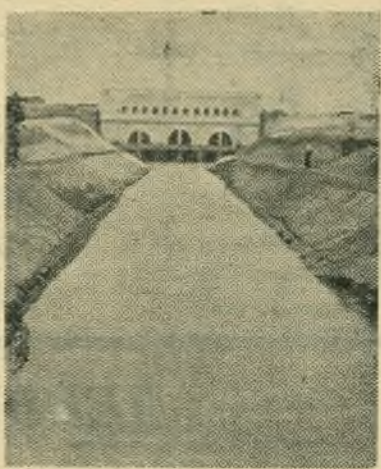
Азербайджанская ССР. На строительстве второй очереди Самур-Дивичинского оросительного канала имени Сталина идут последние отделочные работы. Длина второй очереди — 84 километра. На новой трассе канала построено много гидротехнических сооружений: насосные станции, водосбросы, трубопроводы. С пуском второй очереди Самур-Дивичинского канала начнется заполнение Джейран-Батанского водохранилища емкостью в 130 миллионов кубометров.
