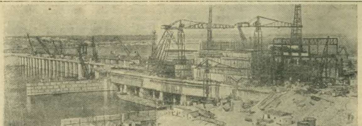
Каховский гидроузел. Развернув социалистическое соревнование в честь XX съезда партии, строители Каховского гидроузла добиваются новых трудовых побед. Перекрыто русло Днепра. Опережая график, идет намыв русловой плотины. Завершается монтаж первого гидроагрегата. Сооружается автодорожный мост. НА СНИМКЕ: сооружение здания ГЭС. Фото Ю. Лихуты.
