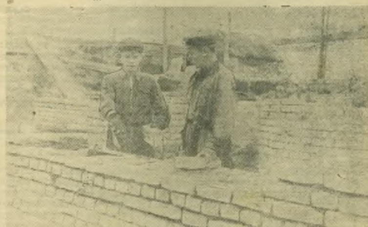
Алексей Делев и Геннадий Белов вместе окончили в прошлом году школу фабрично-заводского обучения № 28 и вместе работают сейчас на сооружении 36-квартирного дома, перевыполняя каждый день норму почти в два раза. Замечательные, трудолюбивые ребята, — говорит о них бригадир треста № 112 тов. Дибров. НА СНИМКЕ: каменщики А. Делев и Г. Белов. Фото Н. Максимова.
