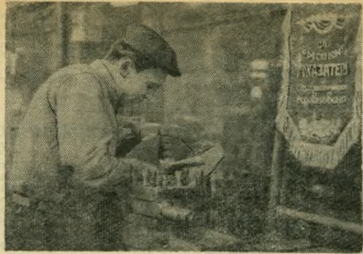
НА СНИМКЕ: тов. Веденин обрабатывает шатун к полумеханическому забрасывателю топлива.
