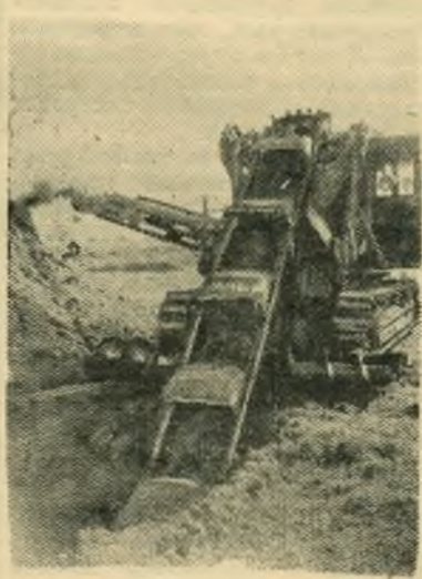
Московская область. На Дмитровском экскаваторном заводе испытывается модернизированный траншейный экскаватор, созданный на базе двух ранее выпускавшихся машин.
