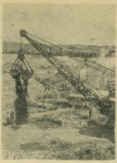
Германская Демократическая Республика. В Лейпциге идет строительство нового стадиона, рассчитанного на 100000 зрителей. НА СНИМКЕ: строительство нового стадиона. Фото Центральбильд.
