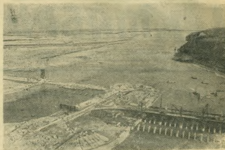
Вид с самолета на строительство здания Куйбышевской ГЭС и район перекрытия русла Волги.
