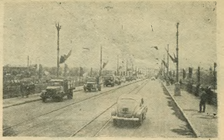
Украинская ССР. В Виннице сдан в эксплуатацию новый железобетонный мост через реку Южный Буг. Он связывает старую часть города с новой.
