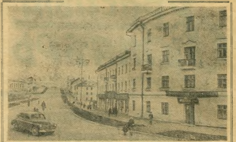
Приморский край. Коллектив строительного треста «Дальморстрой» в городе Находке построил ряд жилых домов, здания больницы, детские ясли и сад, кинотеатр «Строитель», холодильник и другие объекты.
