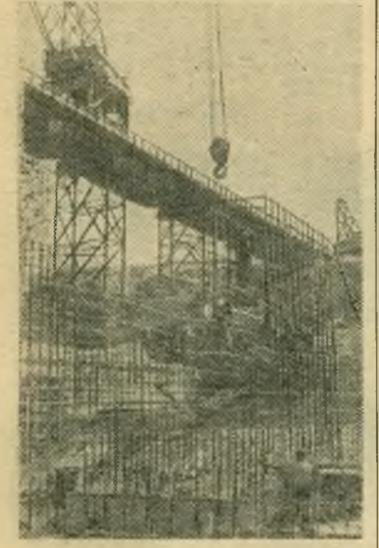
Таджикская ССР. На реке Сыр-Дарья строится крупнейшая в Средней Азии Кайранкумская гидроэлектростанция. К моменту перекрытия русла реки строителям необходимо уложить около 100 тысяч кубометров бетона, установить 3,5 тысячи тонн арматуры и 1.000 квадратных метров плит-оболочек. НА СНИМКЕ: монтаж арматурных конструкций. Фото Б. Зайцева. (Фотохроника ТАСС).
