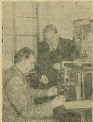
Киев. Научный сотрудник института электротехники Академии наук Украинской ССР В. Э. Моравский под руководством действительного члена Академии наук УССР К. К. Хренова и при участии доцента Киевского политехнического института С. В. Свечникова создал шовную конденсаторную машину «ШКМ-1» для сварки металлических деталей толщиной от сотых долей миллиметра до 0,4 миллиметра.
