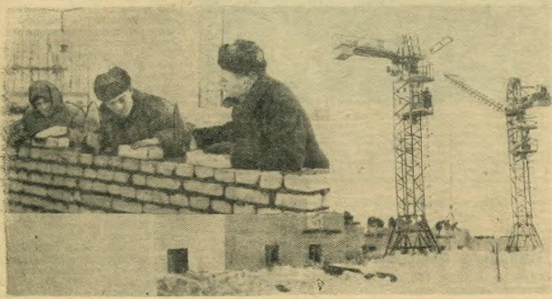
Директивы XX съезда КПСС воодушевляют советских людей на новые трудовые победы. Быстро идет строительство домов комплексная бригада И. М. Дувалева (трест № 24). Бригадир требовательно относится к качеству принимаемой работы от каменщиков, плотников, штукатуров, маляров. НА СНИМКЕ: И. М. Дувалев (первый справа) проверяет качество кладки кирпича, произведенной каменщиками тт. Капишиновым и Саратовчиной на строительстве 12-квартирного дома в поселке нефтяников. Фото Н. Максимова.
