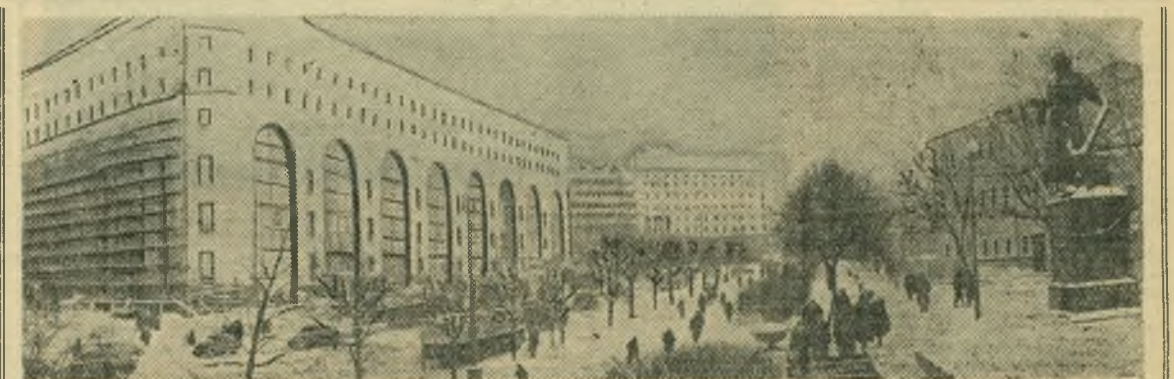
Москва сегодня. Заканчивается наружная облицовка здания нового универмага «Детский мир», сооружаемого в Театральном проезде.
