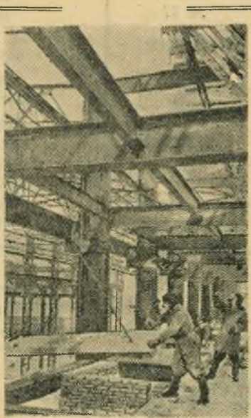
Чувашская АССР. Строящийся Чебоксарский завод тракторных запасных частей является одним из крупных пусковых индустриальных объектов шестой пятилетки. НА СНИМКЕ: монтаж плит перекрытий верхнего этажа специализированного литейного цеха. Фото Б. Мясникова. (Фотохроника ТАСС).
