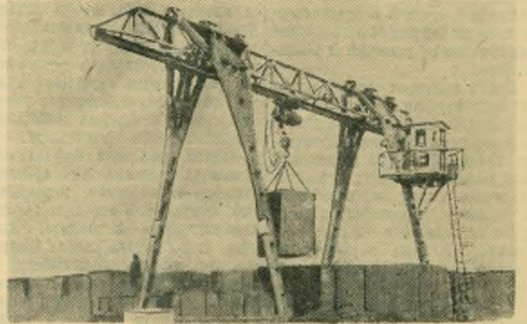
Предприятия Сызранского железнодорожного узла непрерывно оснащаются новой техникой. На товарном дворе ст. Сызрань 1-я установлен электрический козловой кран, при помощи которого производится погрузка контейнеров в вагоны. Это позволило значительно ускорить процесс погрузки и снизить себестоимость этой работы.
