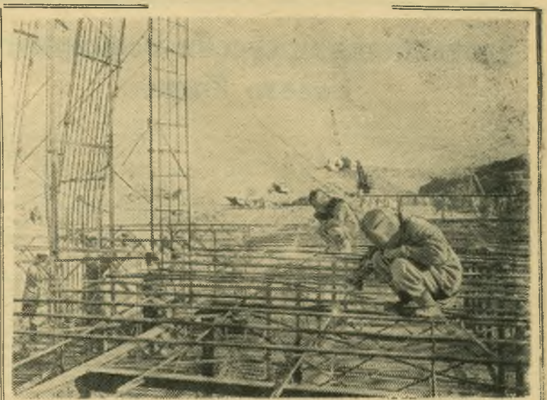
Азербайджанская ССР. Воодушевленные историческими решениями XX съезда КПСС, успешно трудятся строители головного сооружения Верхне-Ширванского оросительного канала. Быстрыми темпами идет бетонирование основания башни водоприемника Ханабадской дамбы. Бригада за смену укладывает по 110 кубометров бетона. Земляные работы на участке завершены на пять дней раньше срока. Намного опередив график, монтажники уже ведут установку металлоконструкций и арматуры на подводящем лотке головного сооружения.
