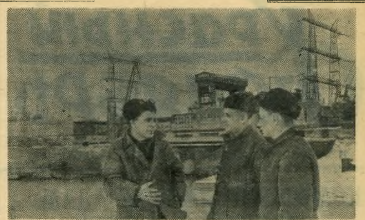
Молотов. 1956 год является годом строительства Камской гидроэлектростанции. Недалек тот день, когда все 24 агрегата будут давать промышленный ток предприятиям Западного Урала. Сейчас строители заняты сооружением объектов второй очереди. В весенний паводок этого года вода будет поднята еще на 8 метров до проектной отметки.
