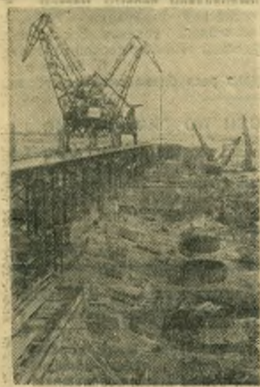
Новосибирская область. В 1957 году должна вступить в строй первая очередь Новосибирской гидроэлектростанции. Строителям гидроузла за оставшийся небольшой срок предстоит проделать огромную работу. В нынешнем году должно быть уложено 290 тысяч кубометров бетона, намыто в русловую и левобережную части плотины 1,700 тысяч кубометров грунта, смонтировано 7,600 тонн металлоконструкций. Зимой будет перекрыто русло Оби. Все это превысит почти вдвое объем строительно-монтажных работ, выполненных в 1955 году. На всех участках стройки развернулось социалистическое соревнование с коллективом строителей Иркутской ГЭС за досрочное выполнение плана первого года шестой пятилетки.
