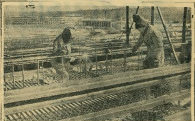
Москва. Заключаются работы по монтажу металлоконструкций крытого спортивного зала на стадионе в Лужниках. НА СНИМКЕ: электросварщики В. И. Поляков и И. Г. Рябштан выполняют сменные задания на 190—200 процентов, производят сварку переходного места фонаря на крытом спортивном зале. Фото А. Сергеева. (Фотохроника ТАСС).
