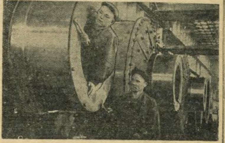
Коллектив гидротурбинного завода освоил производство шаровых углеразмольных мельниц для предприятий Министерства электростанций. На электростанциях, работающих на угле, шаровые мельницы устанавливаются для размалывания угля в порошок, чтобы обеспечить более рациональное его сжигание в котлах.
