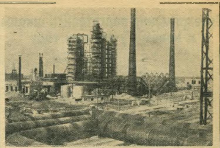
Омск. В сентябре исполняется год, как заработали первые атмосферно-вакуумные трубчатки Омского нефтеперерабатывающего завода. Мощность предприятия систематически растет и к концу шестой пятилетки увеличится почти в пять раз. Сейчас идет монтаж очередной атмосферно-вакуумной трубчатки. В сентябре она даст продукцию. Новая установка будет вдвое мощнее действующих.
