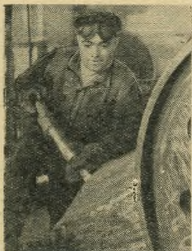
Достойный вклад в шестую пятилетку вносит бригадир обрубщиков гидротурбинного завода В. В. Титов. Ежедневно он выполняет норму на 230 процентов. На СНИМКЕ: В. В. Титов производит обрубку рабочего колеса турбины. Фото В. Владимиров.
